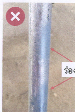
รูปที่ 11 ตัวอย่างอุปกรณ์สลักเกลียวมีร่องรอยการทาสี เพื่อปิดบังผิวเคลือบที่หลุดร่อน
