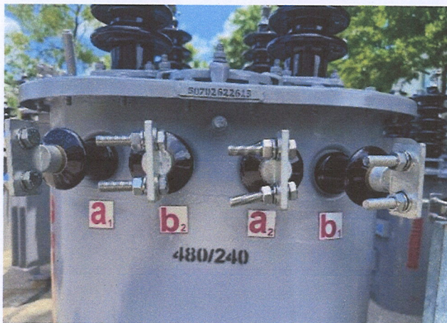
รูปที่ 14 เครื่องหมายระบุลำดับเฟส สำหรับขนาด 30 - 50 kVA
