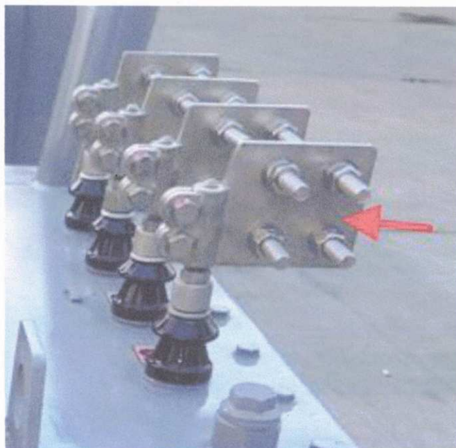
รูปที่ 19 แผ่นขั้วต่อสาย ต้องสภาพเรียบร้อย
