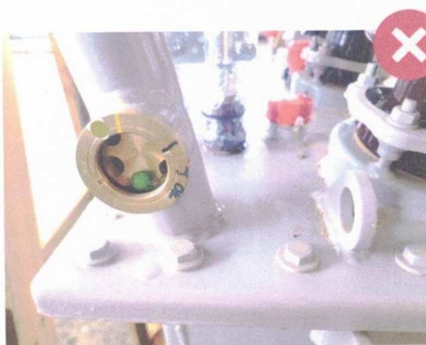
รูปที่ 18 ตำแหน่งการตรวจสอบระดับน้ำมัน
