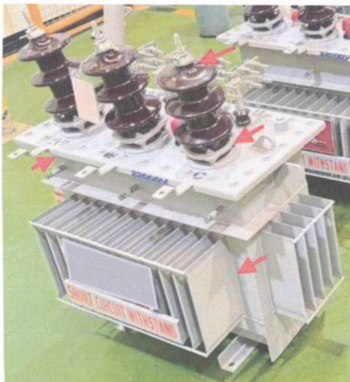
รูปที่ 17 ตำแหน่งการตรวจสอบการรั่วซึมของน้ำมันบนตัวถัง และบุชชิ่ง
