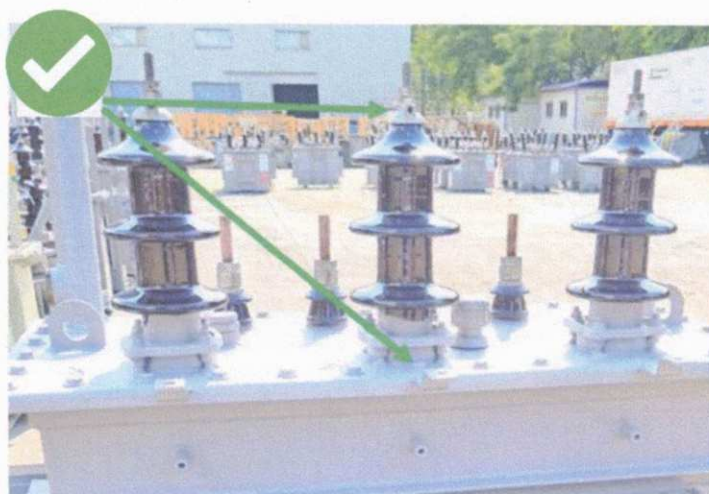
รูปที่ 10 ตัวอย่างการติดตั้งอาร์คชิ่งฮอว์นบนบุชชิ่งด้านแรงดันสูง
