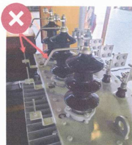
รูปที่ 10 ตัวอย่างการติดตั้งอาร์คชิ่งฮอว์นบนบุชชิ่งด้านแรงดันสูง
