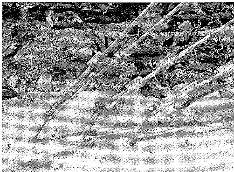
รูปที่ 16 การดึงสายยึดโยง 4 เส้น (ต้น SS-SA-4 หรือต้น SD-SA-3) เข้ากับก้านสมอบก
