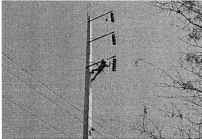
รูปที่ 11 การติดตั้งอุปกรณ์ประกอบหัวเสาด้านทางตรง
