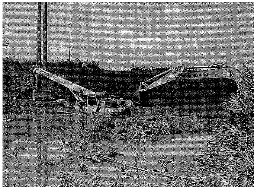
รูปที่ 8 รถเครนลื้อดินตะขบขณะปักเสาคู่
