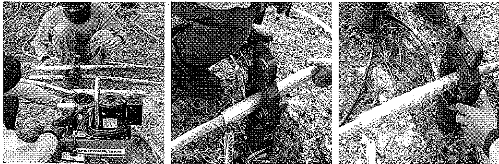
รูปที่ 27 การต่อสายไฟฟ้า ด้วยหลอดต่อสายชนิดบีบรับแรงดึง
