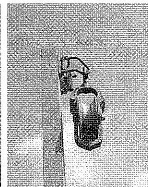
รูปที่ 24 การแขวนรอกพาดสาย สำหรับสายไฟฟ้า และสำหรับสายล่อฟ้า
