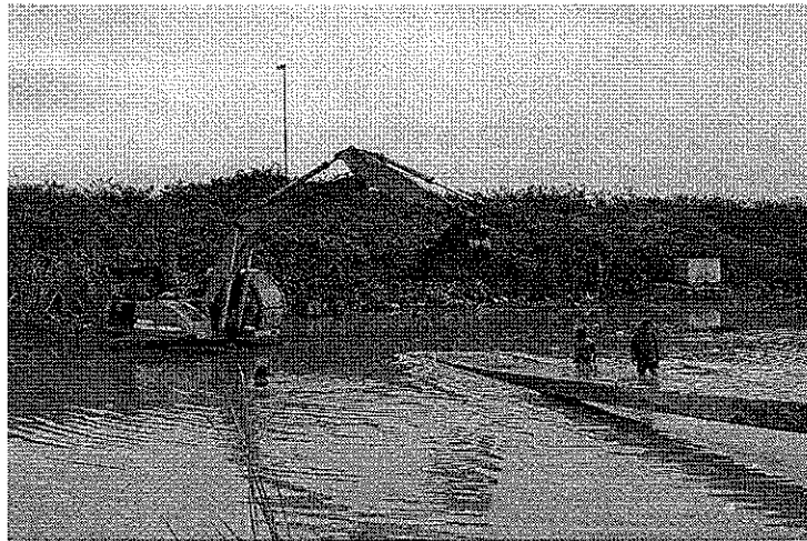
รูปที่ 5 การใช้รถแบ็คโฮช่วยนำเสาเข้าตำแหน่งที่จะปักเสา
