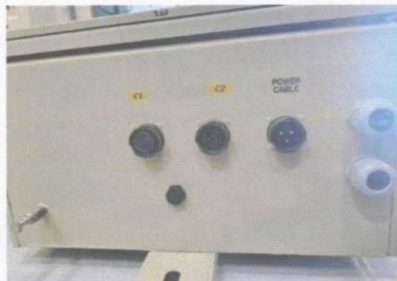
รูปที่ 19 ตัวอย่างจุดเชื่อมต่อสายควบคุม
