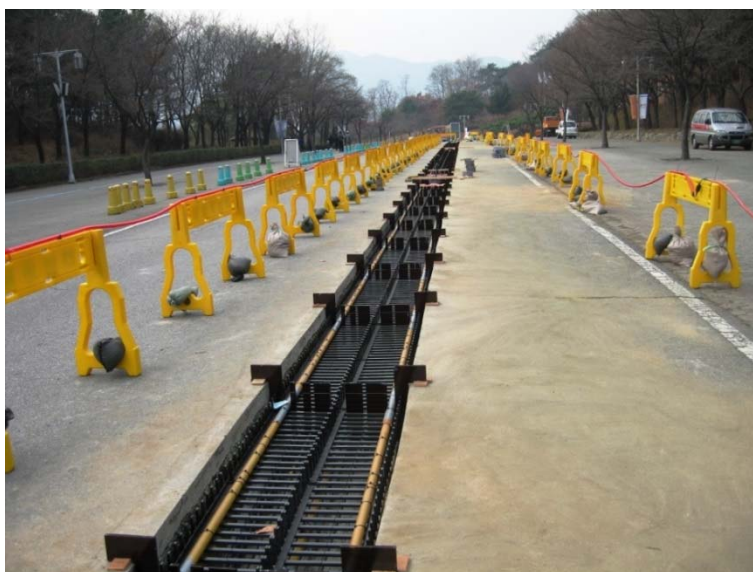
รูปที่ 4-4 ตัวส่งบนพื้นดินของการอัดประจุไฟฟ้าแบบเหนี่ยวนำ
