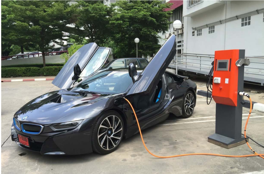
รูปที่ 2-12 เครื่องอัดประจุไฟฟ้าแบบธรรมดาของ กฟน.
