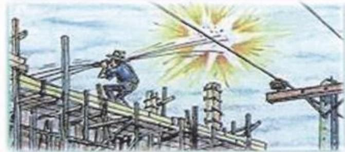
๗. การก่อสร้างตึก อาคารในบริเวณที่ใกล้แรงสูง ผู้ปฏิบัติงานต้องระมัดระวังอย่าให้วัสดุก่อสร้างไปแตะสายไฟฟ้าแรงสูง และผู้ดำเนินการก่อสร้างควรติดต่อกับไฟฟ้าส่วนภูมิภาคในท้องถิ่นเพื่อทำการครอบนวนที่สายไฟฟ้าแรงสูงให้ ซึ่งจะช่วยให้ปลอดภัยในการปฏิบัติงาน
